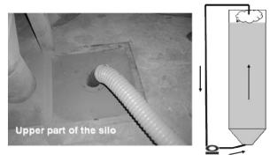
**Fig. 4** Phosphine recirculation system (J-System)
